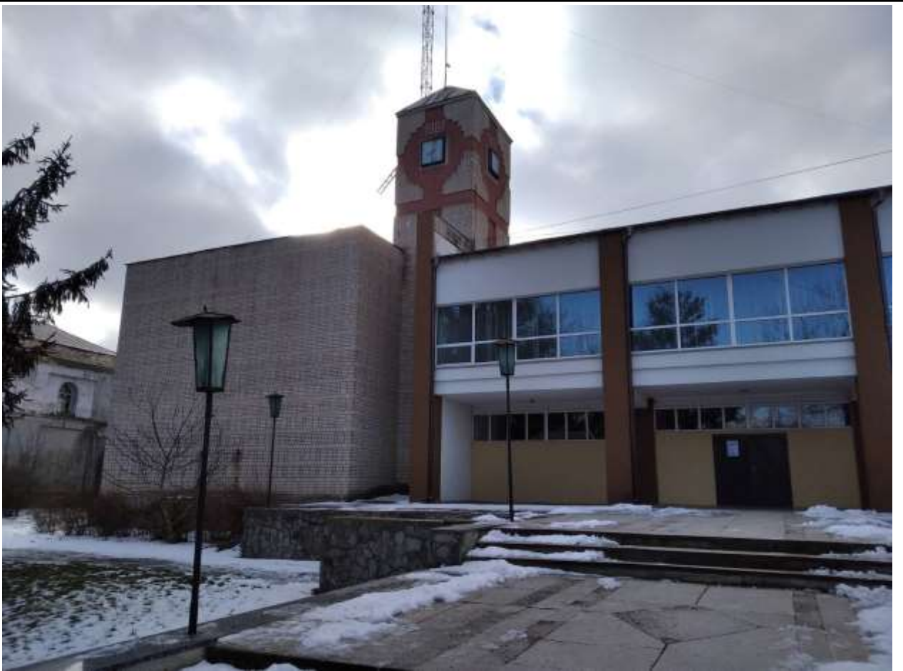
Фото 1. Загальний фасаду будівлі.
